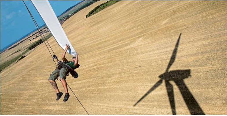
Schwindel- und angstfrei müssen die Monteure bei den Wartungsarbeiten sein.
